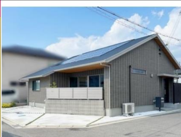
太陽光発電(3.84kW)、オール電化住宅
