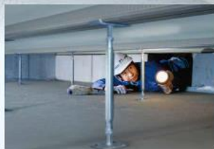
専任スタッフが定期点検を実施し、長期間にわたってお客さまの住まいをサポート。
